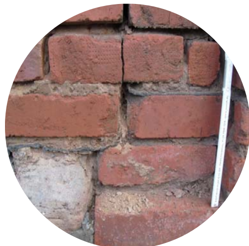
Abbildung 29: UB3; Detailansicht Trennriss und unterbrochene horizontale Dichtung
