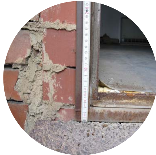
Abbildung 9: UB1; Detailansicht Fußbodenaufbau des mittleren Raums (früher Post- und Vereinsraum)
