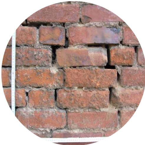
Abbildung 4: UB1; Detailansicht Verkrustung der Steinoberfläche und Fehlstellen der Fugenausbildung
