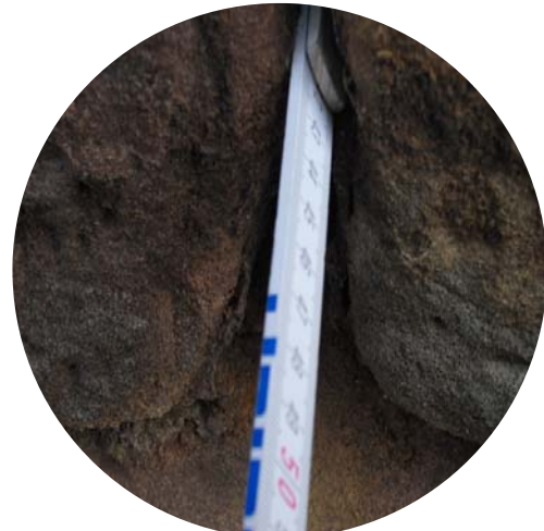
Abbildung 22: UB2; Detailansicht maximale Fugentiefe Sandsteinsockel
