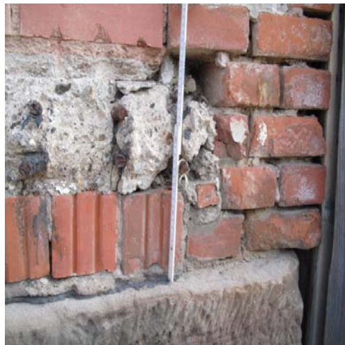
Abbildung 17: UB2; Überblick rechtes Ende der ehemaligen Stahlbeton- Kragplatte
