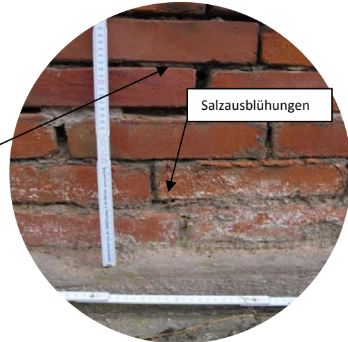
Abbildung 3: UB1; Detailansicht Salzausblühung auf der Oberfläche
