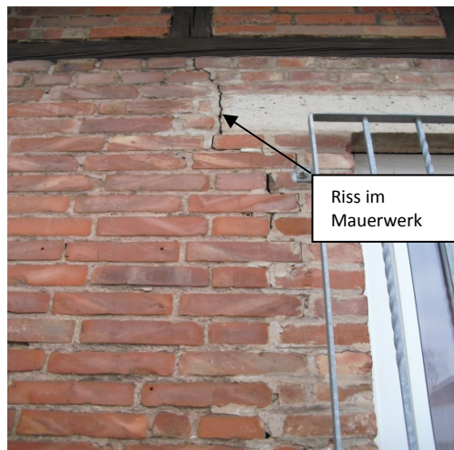
Abbildung 10 : UB1; Überblick vertikaler Rissverlauf Fenstersturz und Leibung linkes Fenster ehemalg Post- und Vereinsraum
