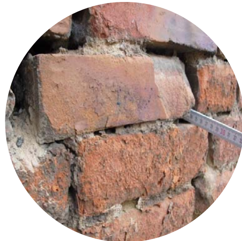
Abbildung 5: UB1; Detailansicht Verkrustung der Steinoberfläche sowie Auswitterung und Fehlstellen der Fugenausbildung
