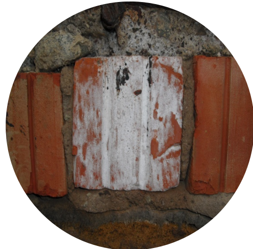
Abbildung 20: UB2; Detailansicht der Salzausblühungen unterhalb der ehemaligen Stahlbetonkragplatte
