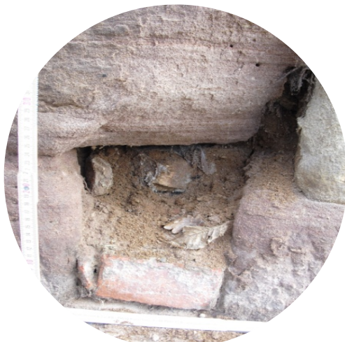
Abbildung 23: UB2; Detailansicht Lückenfüllung mit Ziegelmaterial im Sandsteinsockel
