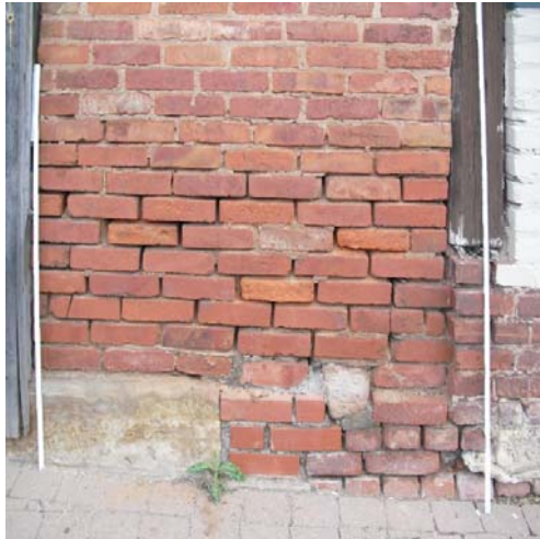
Abbildung 26: UB3; Überblick Schadensbereiche der untersuchten Ziegelmauer
