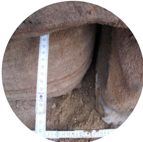
Abbildung 21: UB2; Detailansicht Fugenbild Sandsteinsockel
