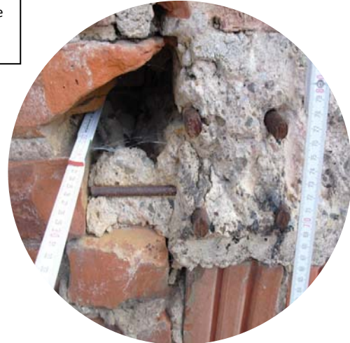
Abbildung 16: UB2; Detailansicht Betonausbruch links
