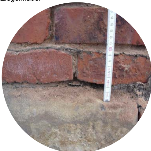
Abbildung 28: UB3; Detailansicht horizontale Dichtung
