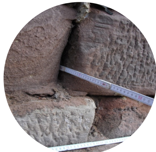
Abbildung 24: UB2; Detailansicht Verwitterung und Abplatzungen Oberfläche Sandsteinsockel
