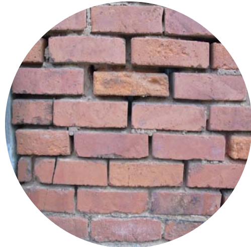
Abbildung 27: UB3; Detailansicht Auswitterung der Fugen
