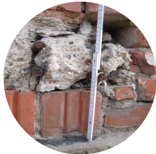
Abbildung 18: UB2; Detailansicht Betonausbruch rechts
