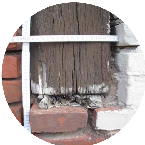
Abbildung 30: UB3; Detailansicht beschädigter Auflagerbereich des Holzpfostens
