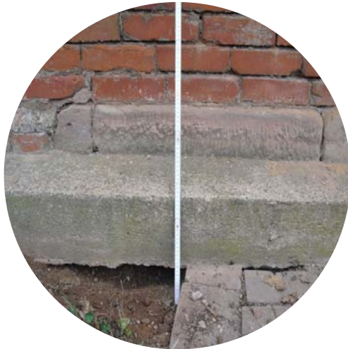
Abbildung 8: UB1; Detailansicht anbetonierter Betonbalken des Sandsteinsockel
