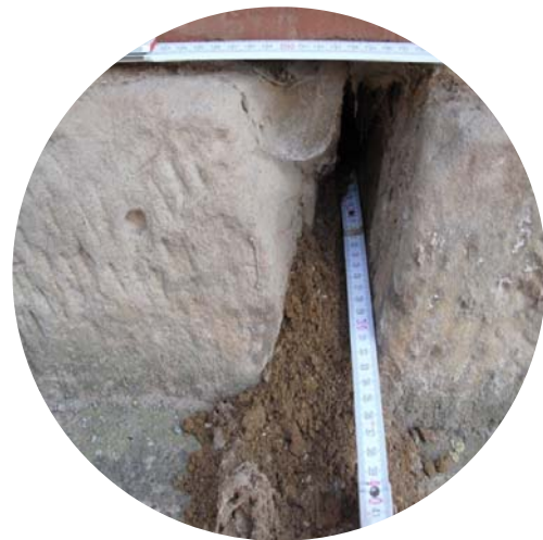
Abbildung 7: UB1; Detailansicht Fugenausbruch
